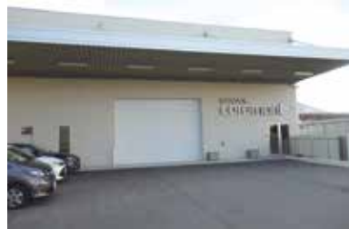
▲コロマン・センターの外観
