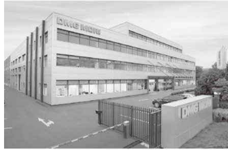
▲センタの外観(敷地面積1,735㎡)
