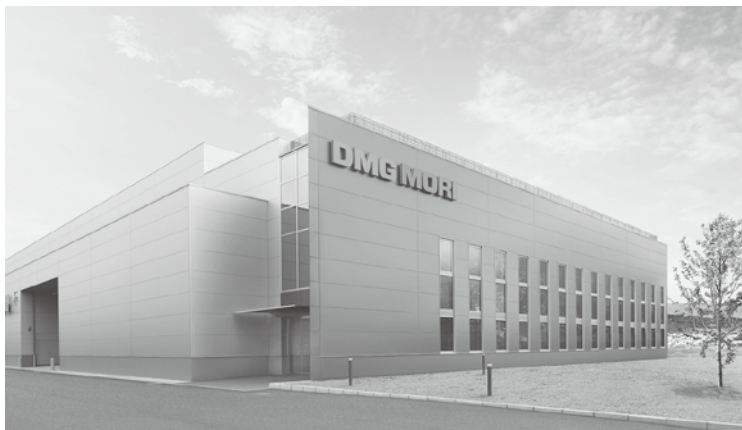
▲システムソリューション工場外観
